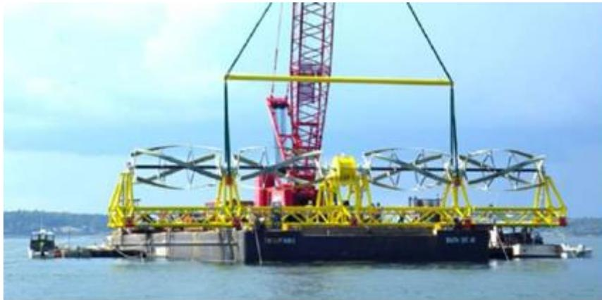
Figura 3.13: Transporte de la turbina de flujo cruzado TidGen, hacia su emplazamiento en la bahía de Fundi. Fuente: <http://www.orpc.co>
