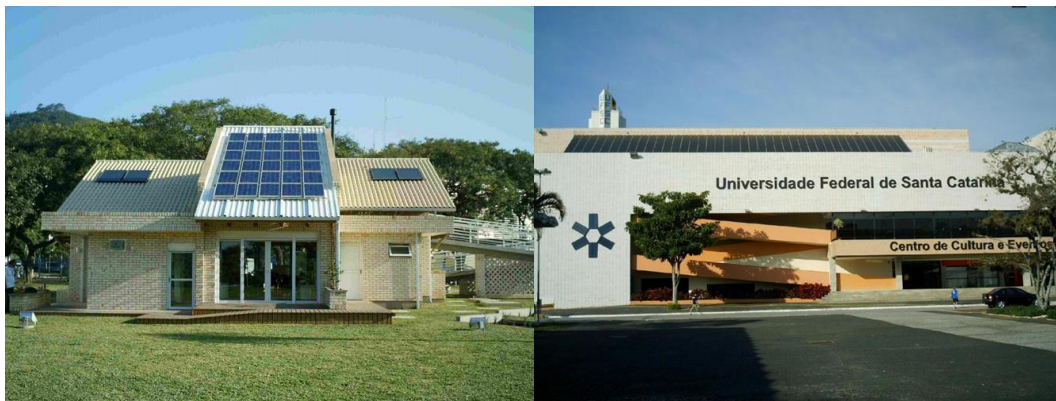
Figura 20. Sistema fotovoltaico tradicional de techo de silicio cristalino en una casa familiar (izquierda) y Sistema fotovoltaico de techo de silicio amorfo de película delgada en el Teatro Universitario de la Universidad Federal de Santa Catarina (derecha), en Florianópolis, Brasil. Fuente: [24]
