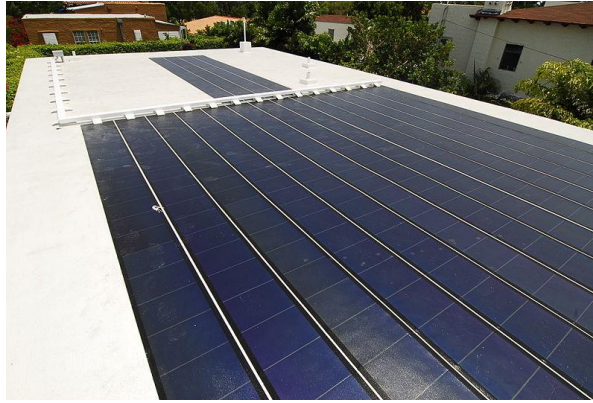
Figura 12. Instalación solar de a-Si sobre el techo de una residencia. Fuente: Wikipedia.
