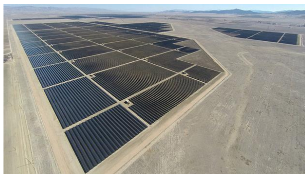
Figura 13. Planta fotovoltaica Topaz Solar de 550 MW de CdTe localizada en California, Estados Unidos. Fuente: TechXplore.com.
