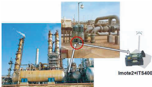
Figura 1: Aplicación de monitorización de audio para dos bombas en industria química.
