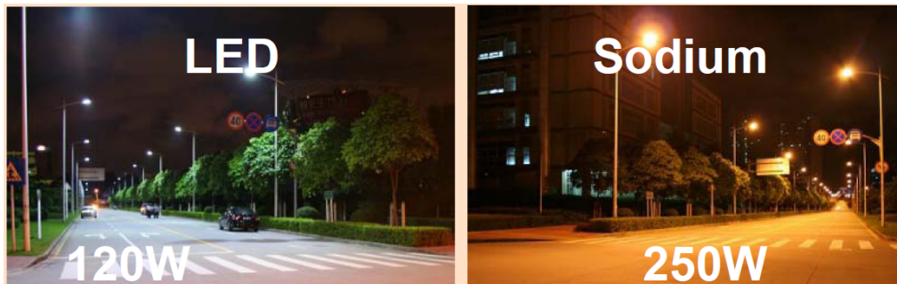
Figura 19. Mejora de la calidad de la iluminación mediante LED
