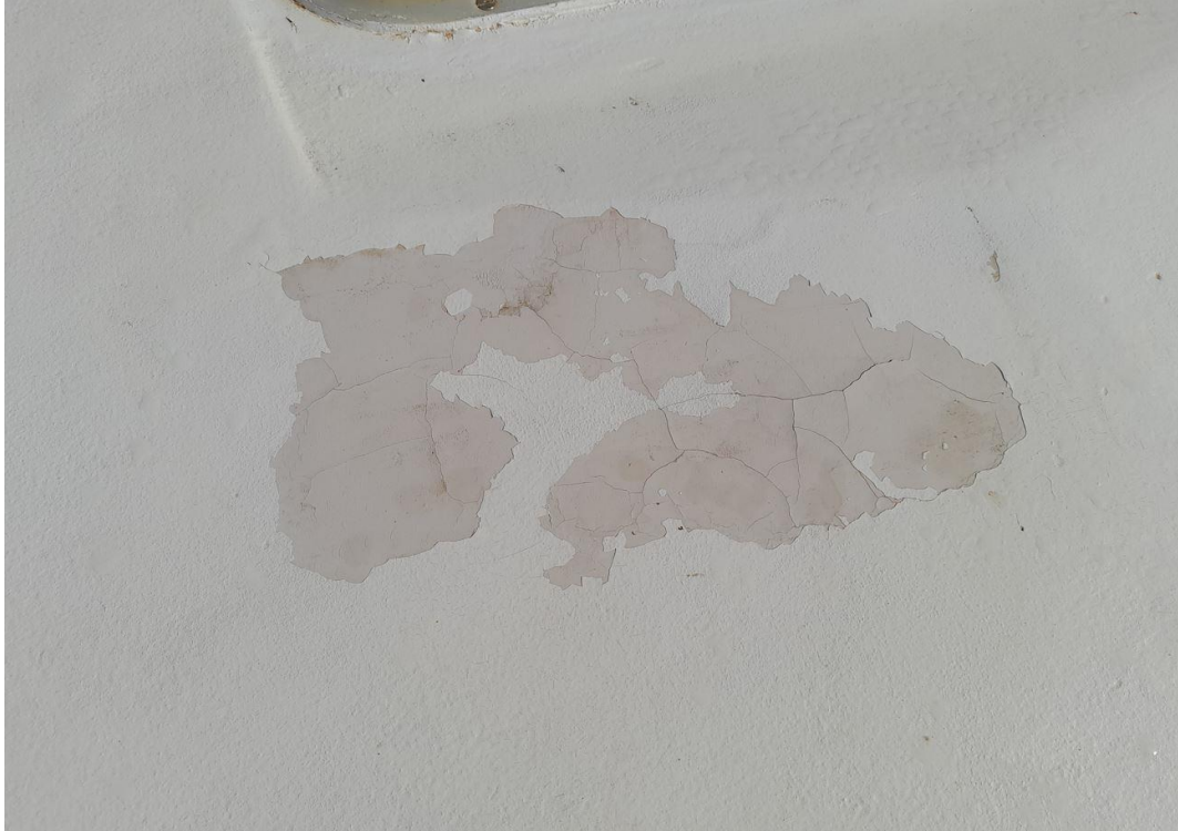
Ilustración 12. Ejemplo mala aplicación Gel-Coat y pintura en cubierta embarcación de recreo.
