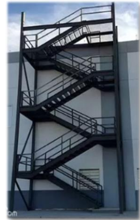
Ilustración 12. Escalera de emergencia
