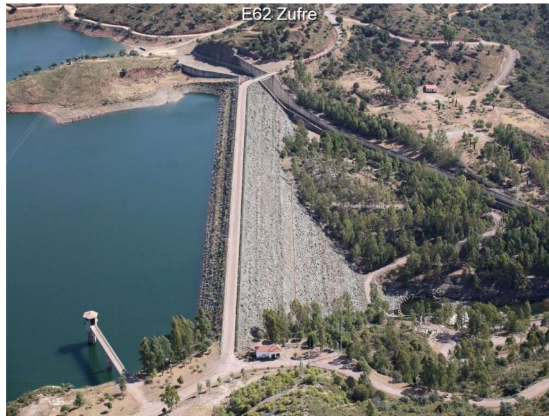
Figura 11. Presa de materiales sueltos homogénea
