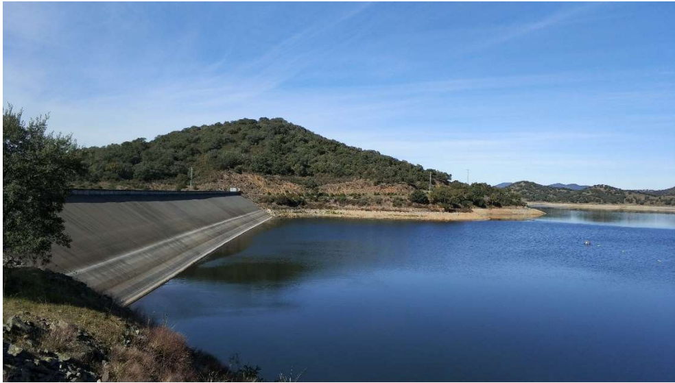
Figura 9. Presa de escollera con pantalla de hormigón
