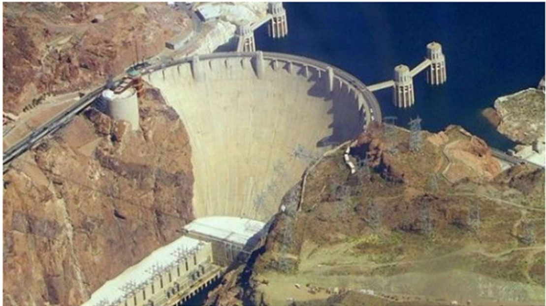
Figura 7 Presa Arco-gravedad. Hoover (Río Colorado, frontera entre los estados de Arizona y Nevada).
