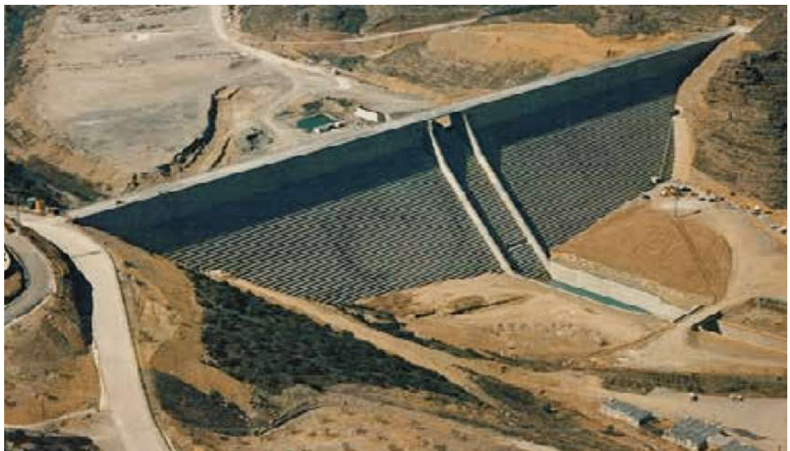
Figura 5. Presa de hormigón compactado con Rodillo. El Val (España)
