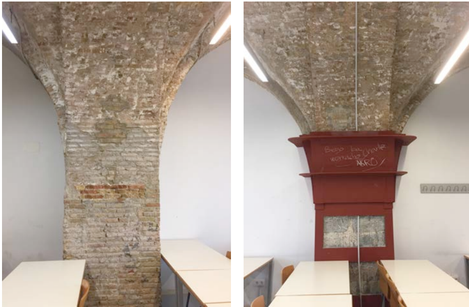
Imagen 18 Materialidad de la estructura en la Planta baja de la ETSIT
