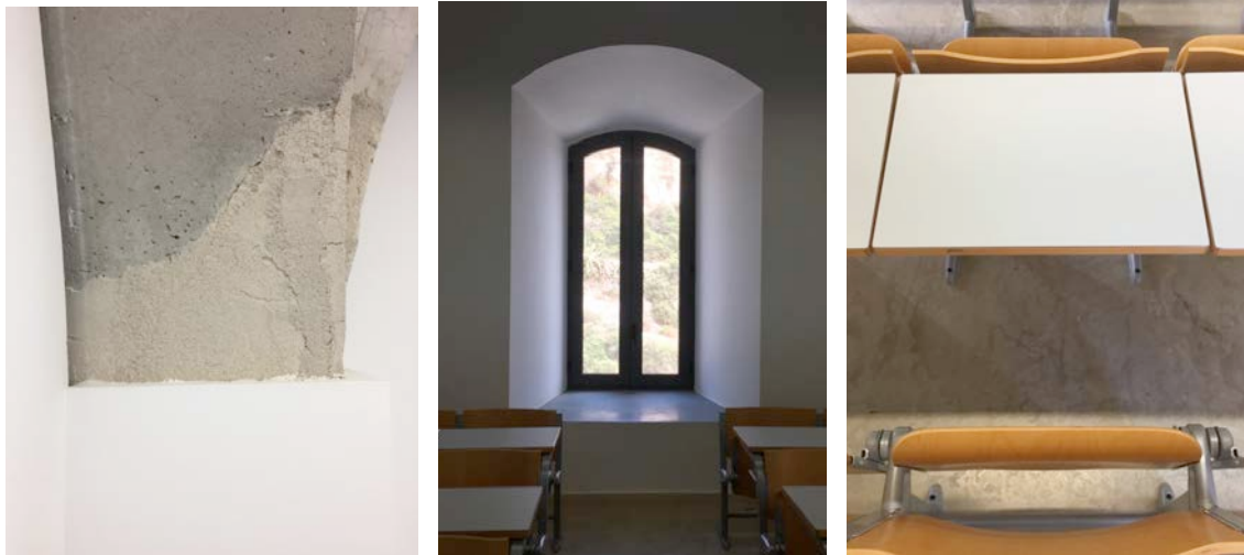
Imagen 23 Materialidad en las aulas de la Planta primera de la ETSIT
