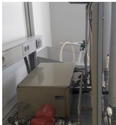
Figura 1.3 - Radiador y bomba
