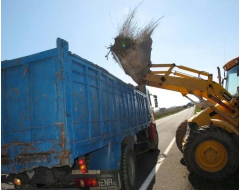
Fotografía 4.2. Pala excavadora cargando sobre un remolque el suelo y las plantas de *Phragmites australis*.
