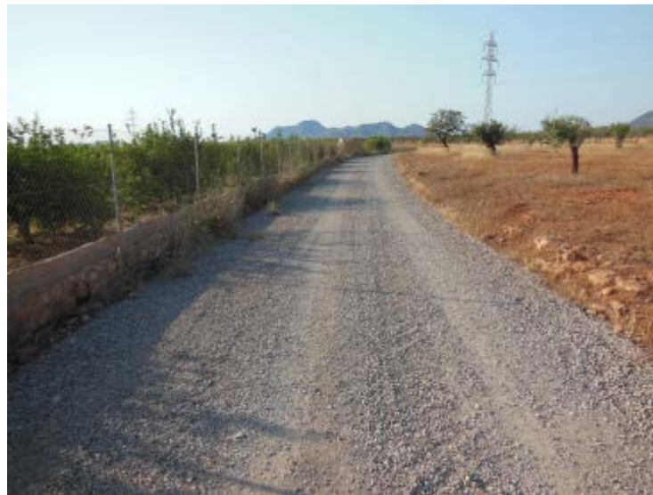
Figura 18. Camino rural de zahorra estabilizada.
