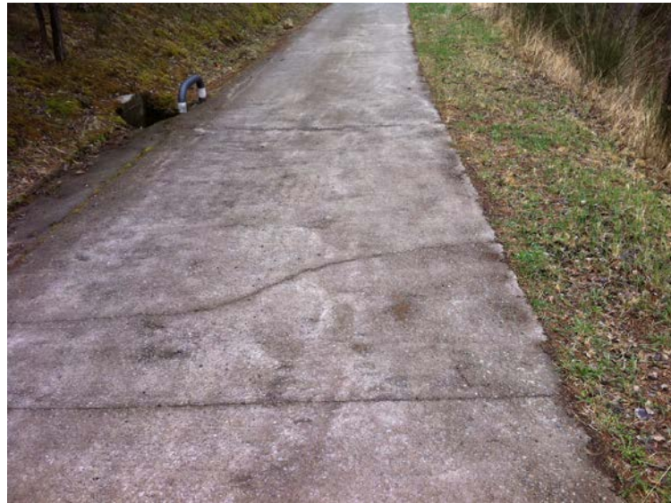
Figura 19. Camino rural de hormigón
