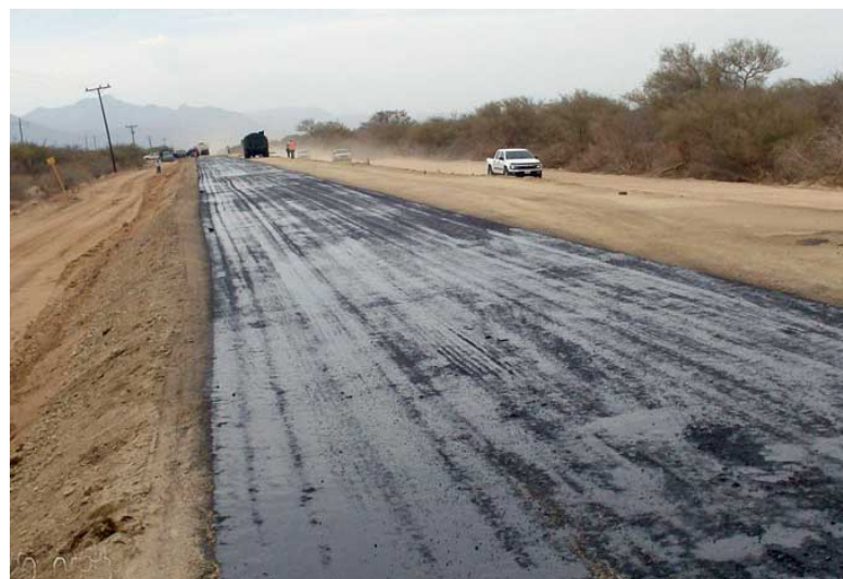
Figura 20. Riego asfáltico en camino rural.
