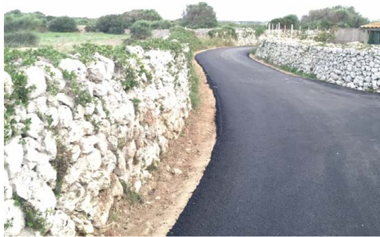
Figura 16. Mezcla bituminosa en camino rural.
