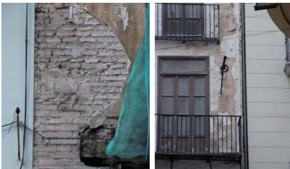
Fig. 4. Detalle del desprendimiento del revestimiento (izquierda) y del abolsamiento superficial del revestimiento (derecha) en dos edificios históricos de Valencia (V. La Spina).
