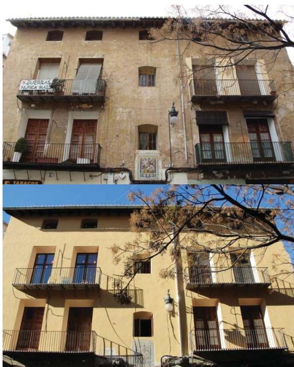
Fig. 1. Edificio rehabilitado que ha perdido su revestimiento histórico en la calle Salador Giner nº 1 de Valencia (V. La Spina).
