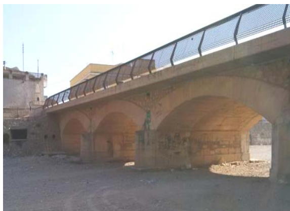
Fig. 2. Puente de San Francisco situado en Fuente Álamo.
