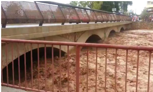
Fig. 4. Puente de San Francisco situado en Fuente Álamo durante la avenida del 28/09/2012.
