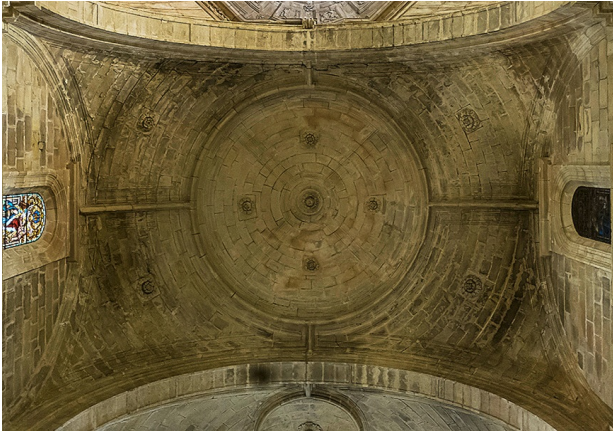
Fig 2. Bóveda baída por hiladas redondas sobre planta rectangular en la Iglesia de Santo Domingo (Sanlúcar de Barrameda, Cádiz). 2011.
