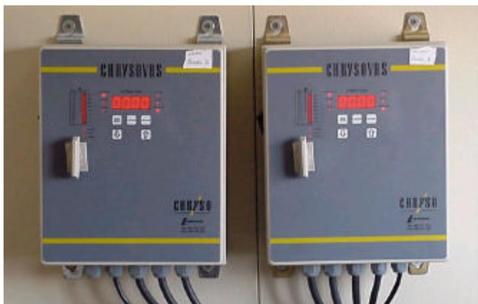
Figura 7.- Contadores de aditivos, situados en la caseta de control.
