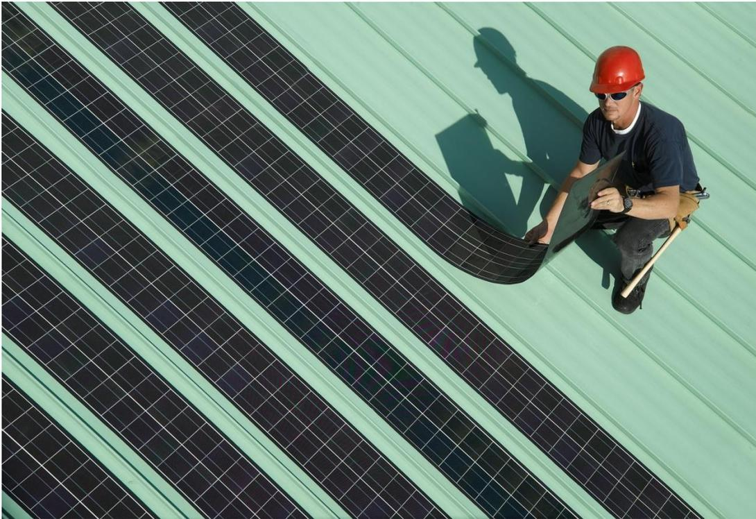
*Figura 33: Instalación de paneles solares orgánicos.[80]*
